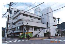
旧市役所跡には、南部出張所等が入る複合施設となっている
